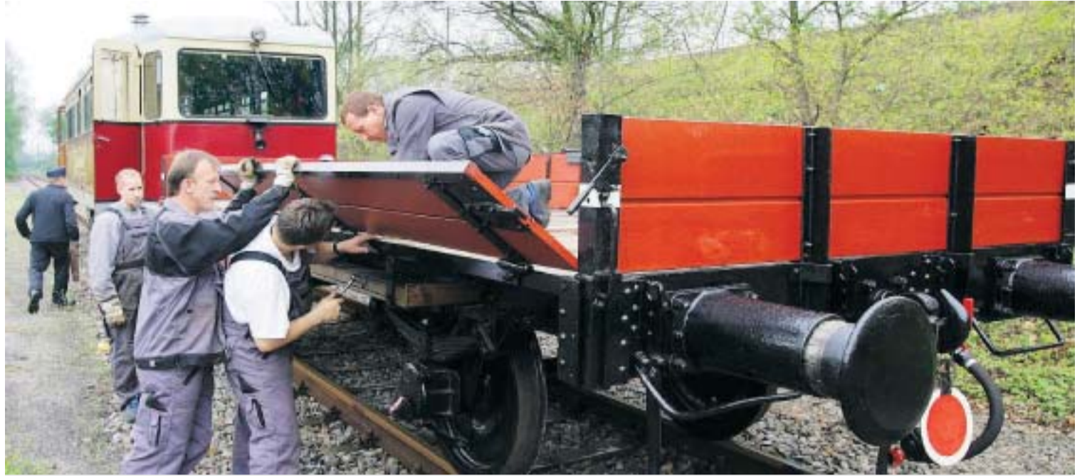
In monatelanger Kleinarbeit haben sechs Arbeitslosengeld-II-Empfänger für die Delmenhorst-Harpstedter Eisenbahnfreunde einen alten Waggon hergerichtet. Der Wagen wird künftig auf den historischen Fahrten genutzt. FOTO: INGO MÖLLERS
